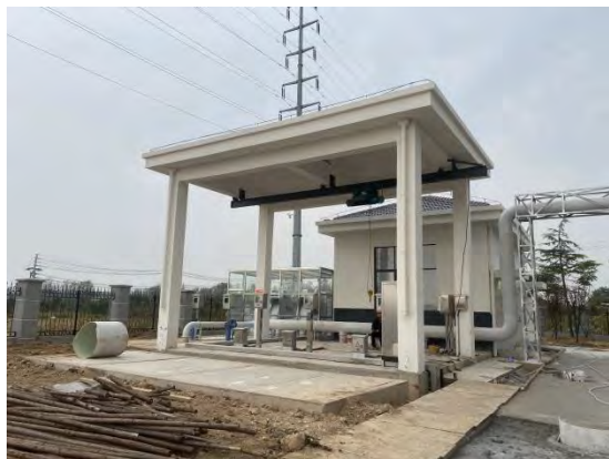
粗格栅及进水泵房
