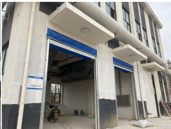
污泥脱水机房
