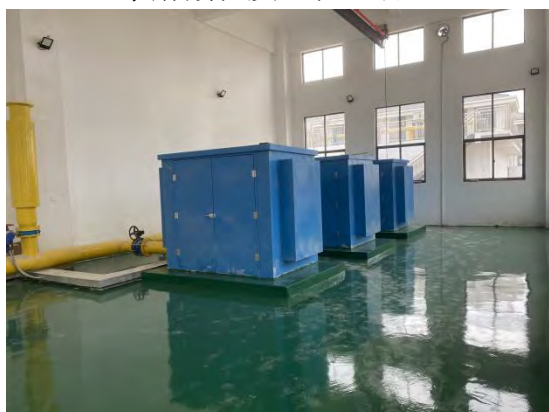
曝气生物滤池
